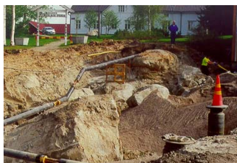
Kuva: Maakivi tierakenteessa
